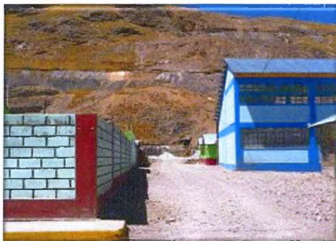
Imagen N° 69 Paratía (3.00) Bocamina de "El Cofre 1", cercana a las Instituciones Educativas, IEl N° 360 e IEP 70426
