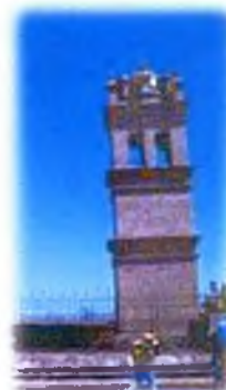
Imagen N° 17 La Torre Viuda
